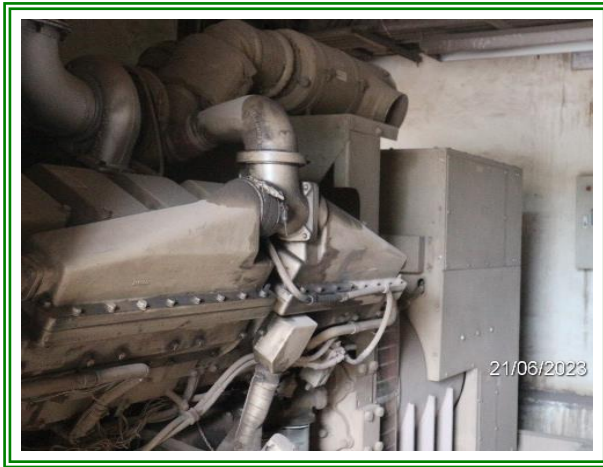
รูปที่ 3-44 ระบบไฟฟ้าสำรองบริเวณเตาหลอม
