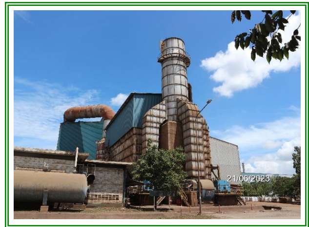
รูปที่ 3-14 ระบบดักฝุ่นแบบ Canopy Hood ที่ใช้ดูดฝุ่นละอองและ Fume ที่ล้าเสี่ยงเข้าไปบำบัดโดยผ่านระบบดักฝุ่นแบบถุงกรอง (Bag Filter)
